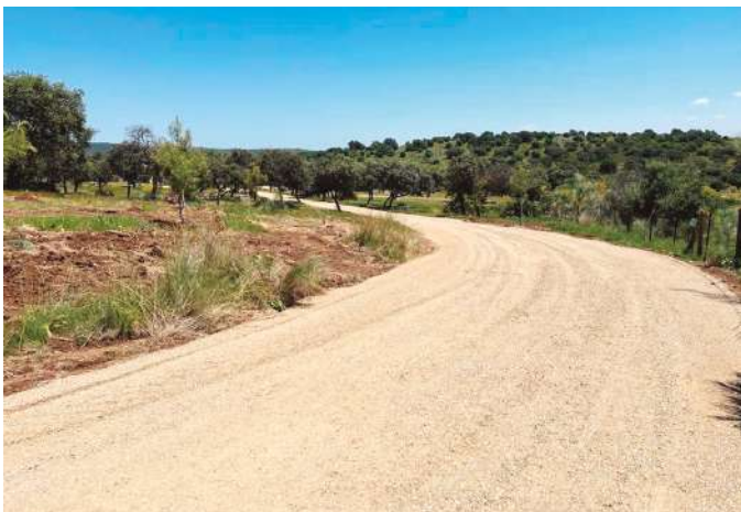
Reparación del Camino de La Madroña y de las Majadas.
