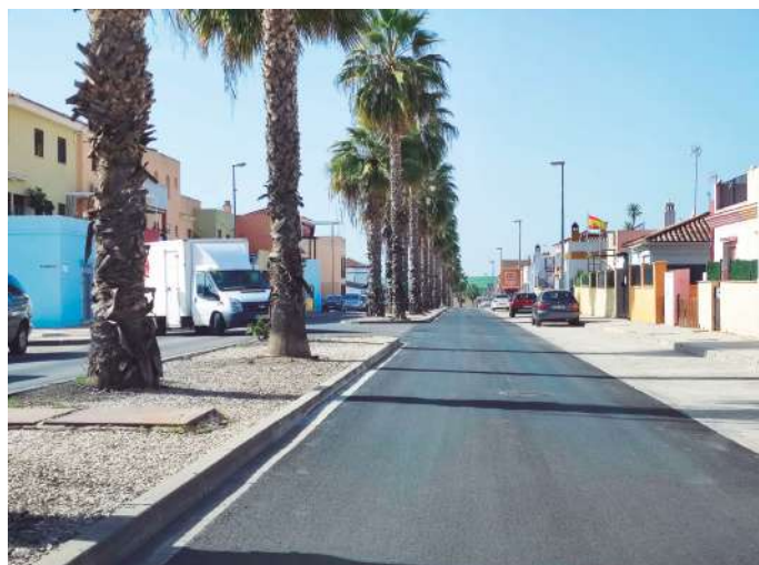
Asfaltado de calles.
