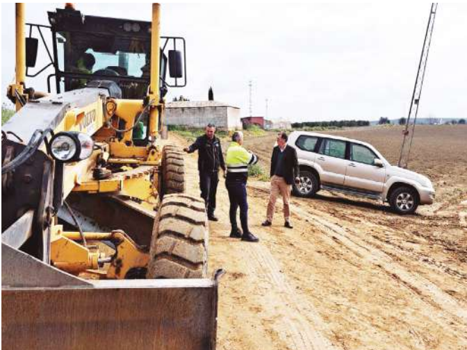
Inicio de obras de reparación del Camino de Las Parcelas.
